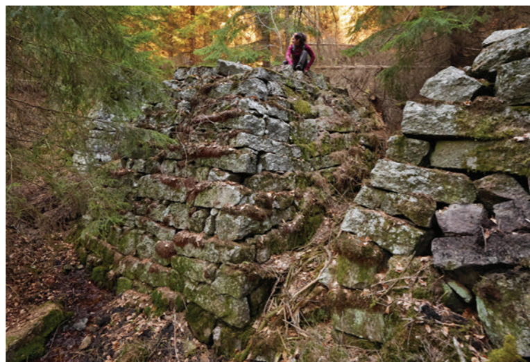
↑ Kamenné pilíře vodního smyku, který přemostoval ponornou část Černé Nisy (foto Ivan Rous)
